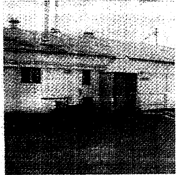
PBF-742 @ Bldg PBF/PRZ-601
